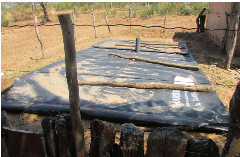
Foto 11. Totoral, geomembrana sin agua
