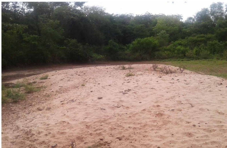
Foto 9. Atajado de Timboycito, lleno de arena y sin agua
